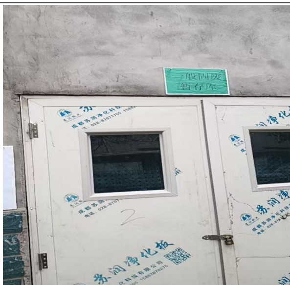
一般固废暂存间
