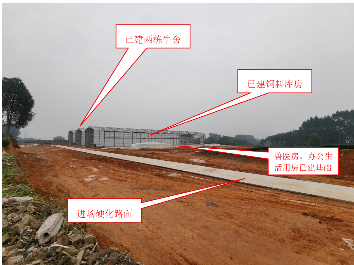
现场现状调查照片
