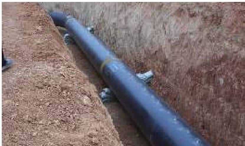
图 3.2-3 平原地区管沟开挖及布管实景图
